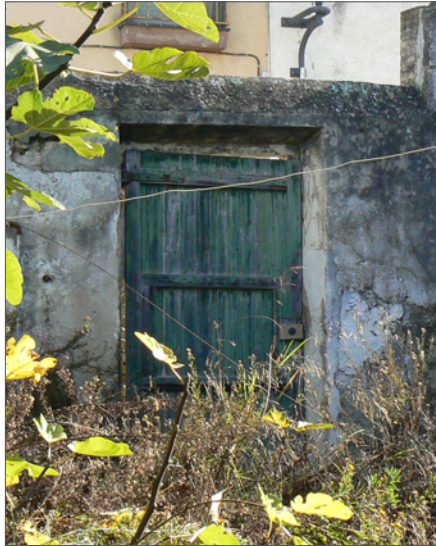
Porta fusta E.A. (Vista interior parcel·la)
