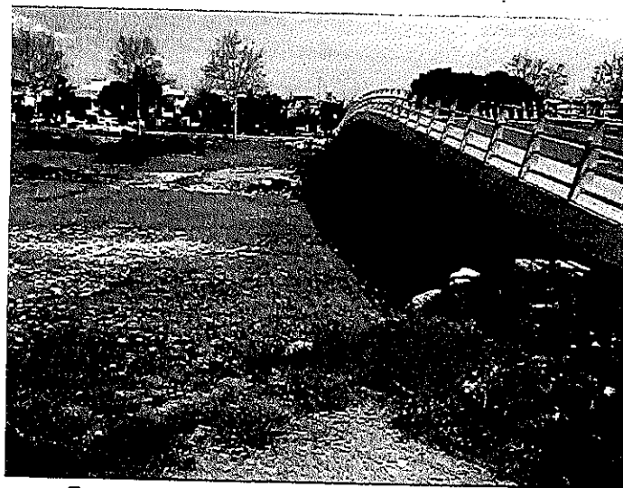
Zona natural afectada per l'execució de l'obra.
