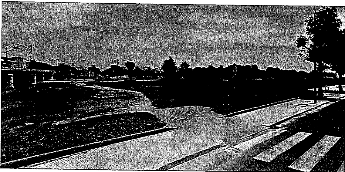
Zona d'accés a la zona d'obres.
