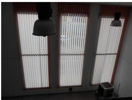
Finestrals que quedarien coberts amb la solució del mural.
