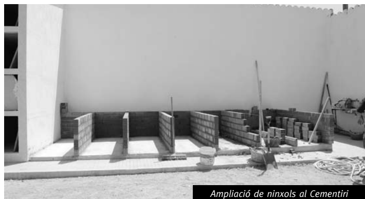
Ampliació de nínxols al Cementiri
