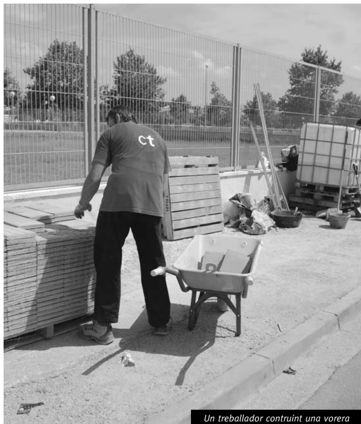
Un treballador contruint una vorera
