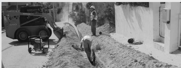
Imatges de les obres de canalització
