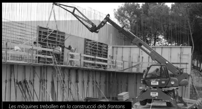
Les màquines treballen en la construcció dels frontons
