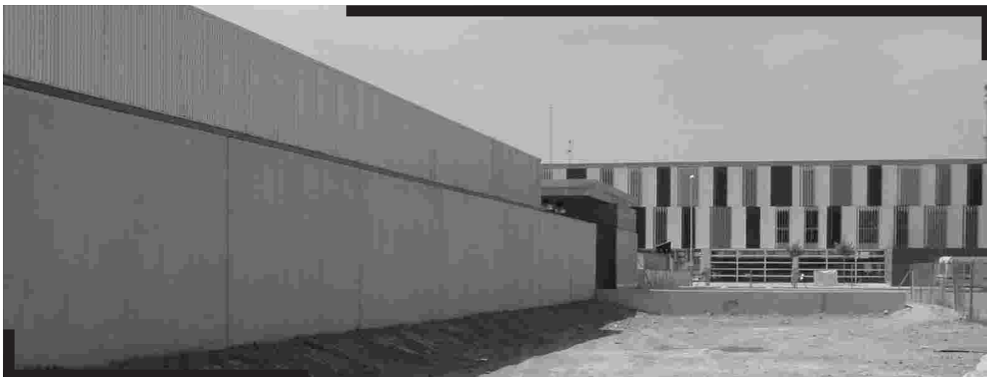
Entrada al camp de futbol i l'IES Cubelles. La urbanització dels accessos a la instal·lació i a l'IES Cubelles estan pressupostats
