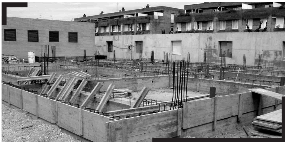
Les obres d'ampliació de la Il·lar d'infants avancen
