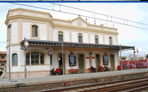
Presentades les obres de millora a l'estació
