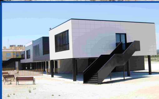
Finalitzen les obres de l'escola Mar i Cel
