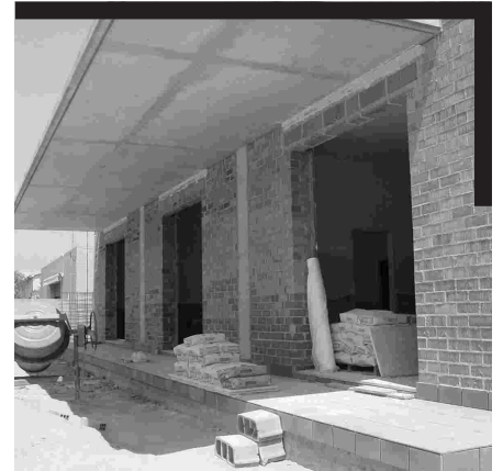
Obres d'ampliació de la llar d'infants que estarà a punt per a l'inici del curs escolar 2006-2007
