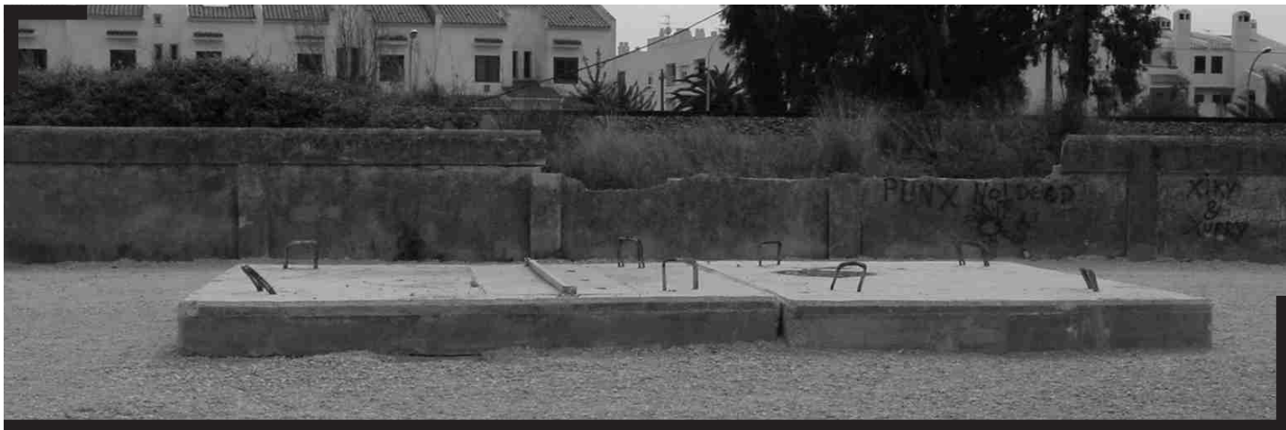
L'estació de bombeig del sector Bardají es troba al carrer Millera.
