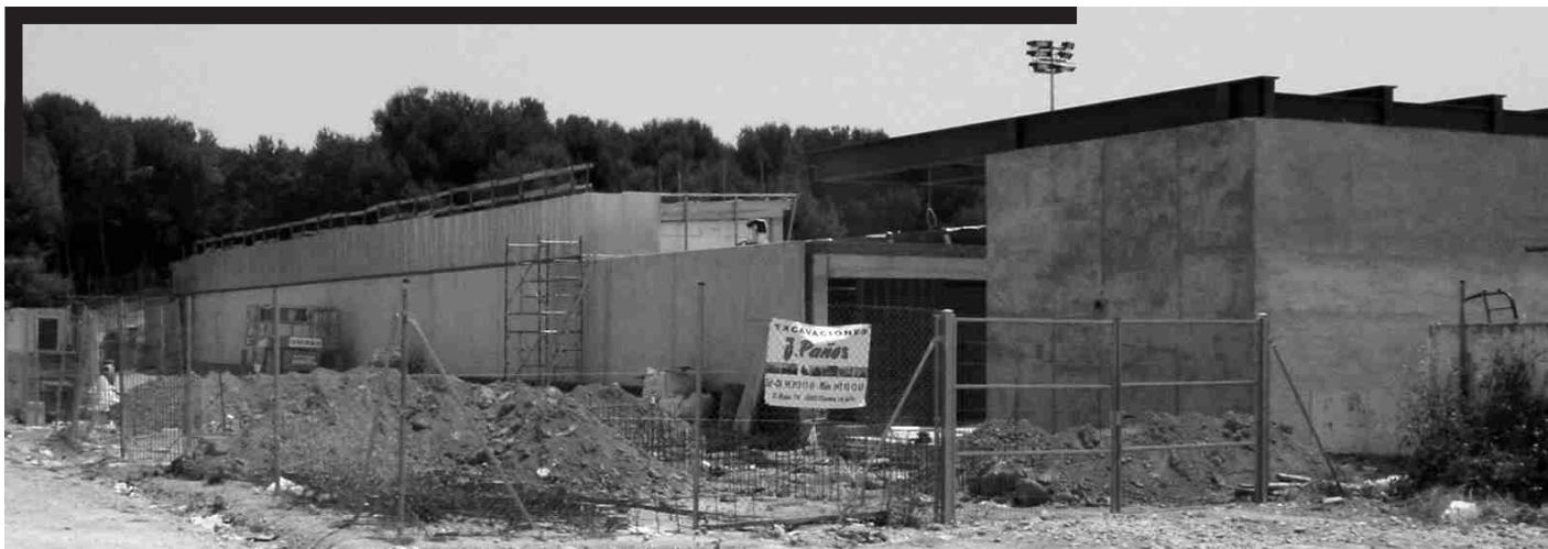
Les obres dels vestidors avancen a bon ritme.
