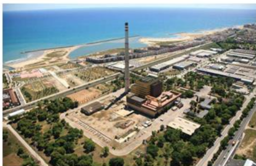
Imatge 1: instal·lacions de la Central Tèrmica en funcionament.
