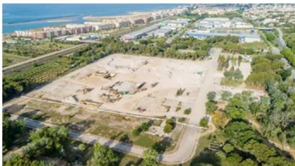
Imatge 2: Estat actual dels sòls
