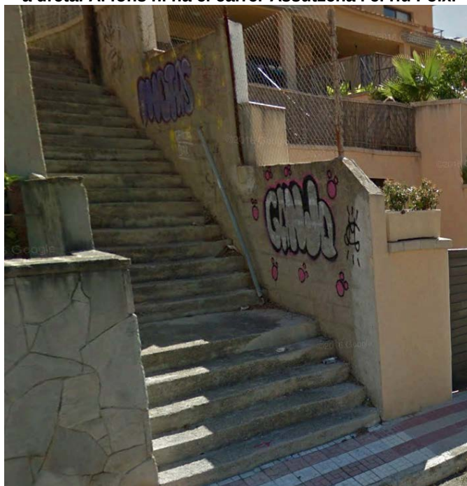
Figura 4: Vista de les escales per sota de les quals passa el sífó de la mina.
