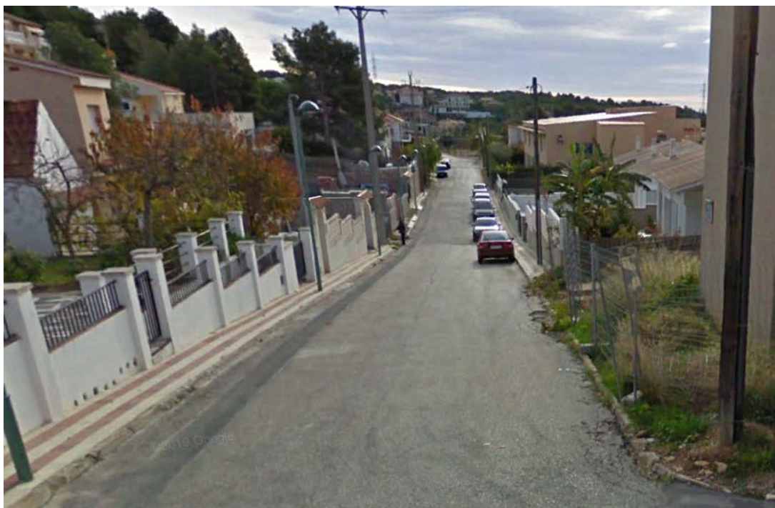
Figura 1: Carrer Gessamí vist des del carrer Dàlia, lloc on es preveu instal·lar la reixa de captació de les aigües superficials procedents del carrer Dàlia. Al fons hi ha el carrer Assutzena i el riu Foix.
