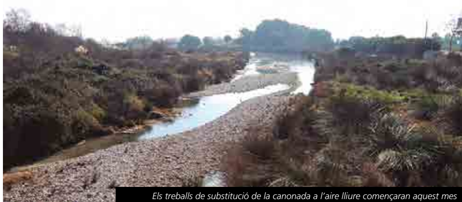
Els treballs de substitució de la canonada a l'aire lliure començaran aquest mes
