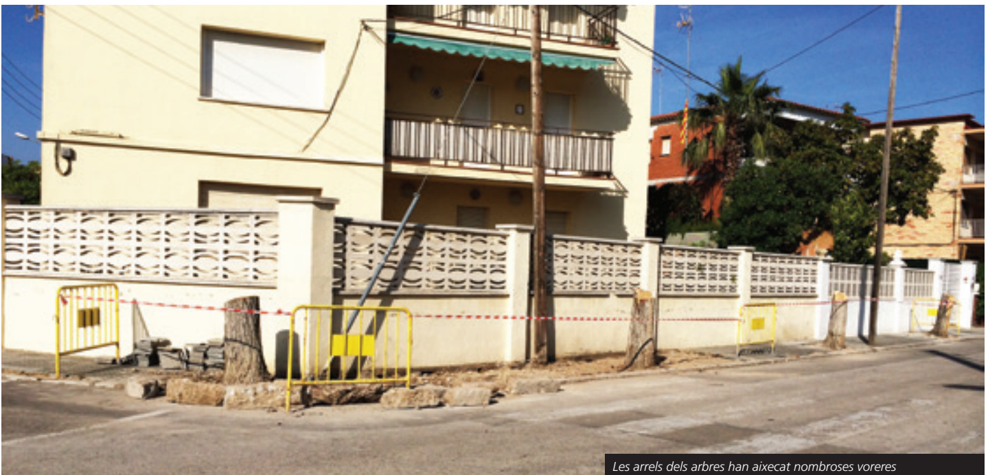
Les arrels dels arbres han aixecat nombroses voreres
