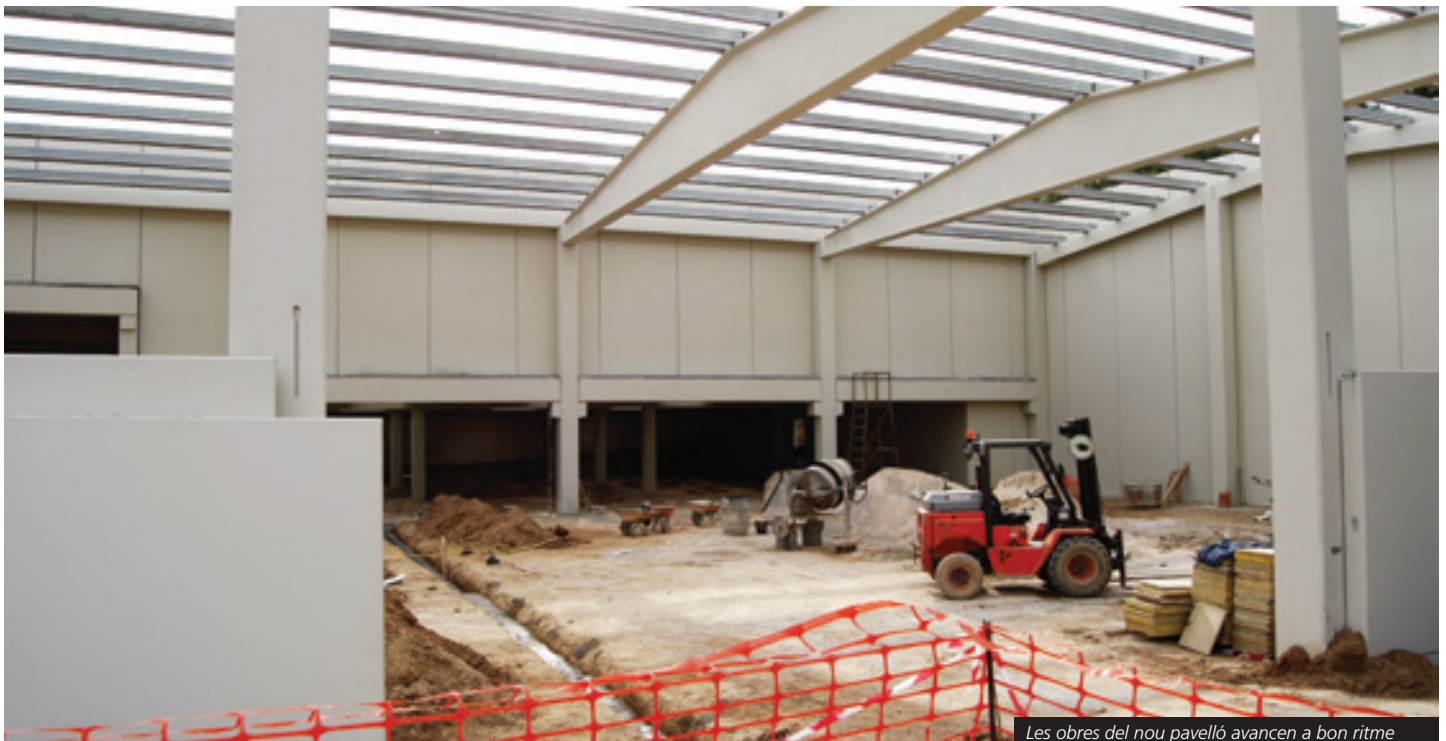
Les obres del nou pavelló avancen a bon ritme
