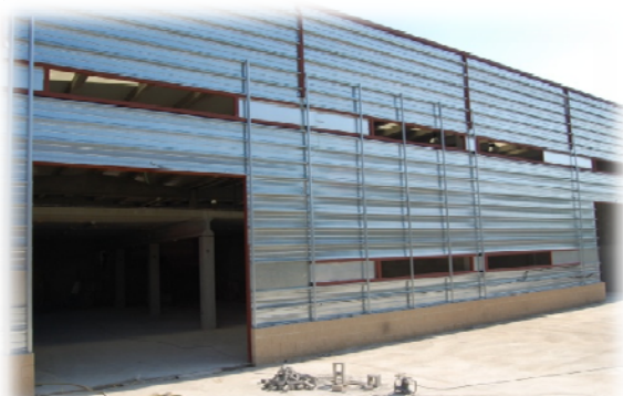
Construcció naus brigada 508.708,96 €
