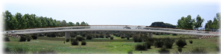
Construcció nou pont sobre el riu Foix
