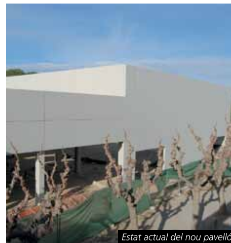
Estat actual del nou pavelló
