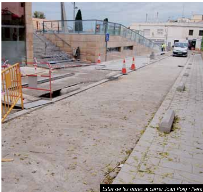
Estat de les obres al carrer Joan Roig i Piera
