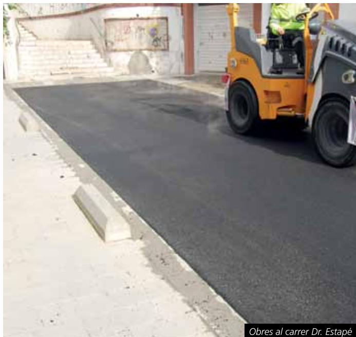
Obres al carrer Dr. Estapé
