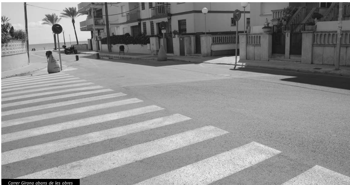
Carrer Girona abans de les obres
