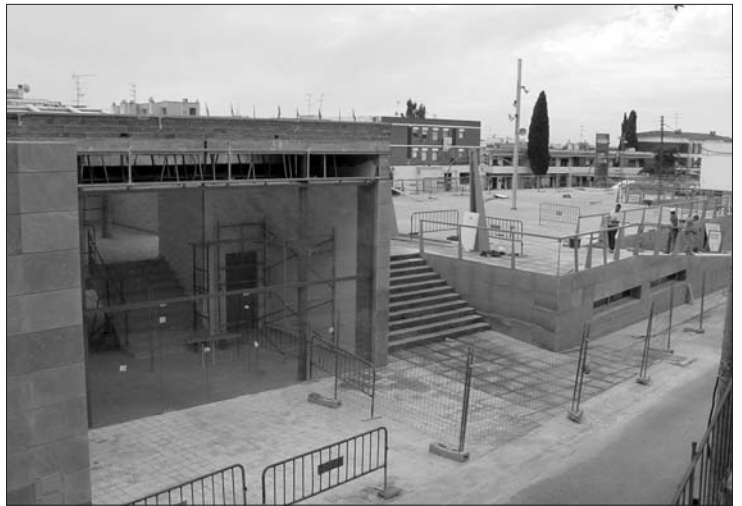
El Centre Social Integrador i de Dinamització Econòmica. El Pla Local Jove girarà al seu voltant
