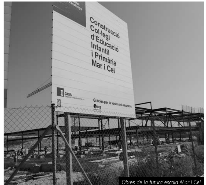
Obres de la futura escola Mar i Cel
