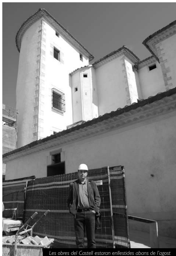
Les obres del Castell estaran enllestides abans de l'agost
