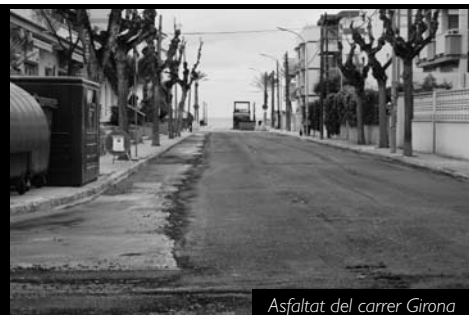
Asfaltat del carrer Girona
