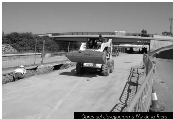
Obres del clavegueram a l'Av. de la Riera
