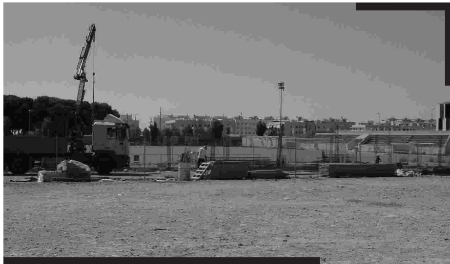
Les obres dels vestidors del camp de futbol. S'ha aprovat la primera certificació.
