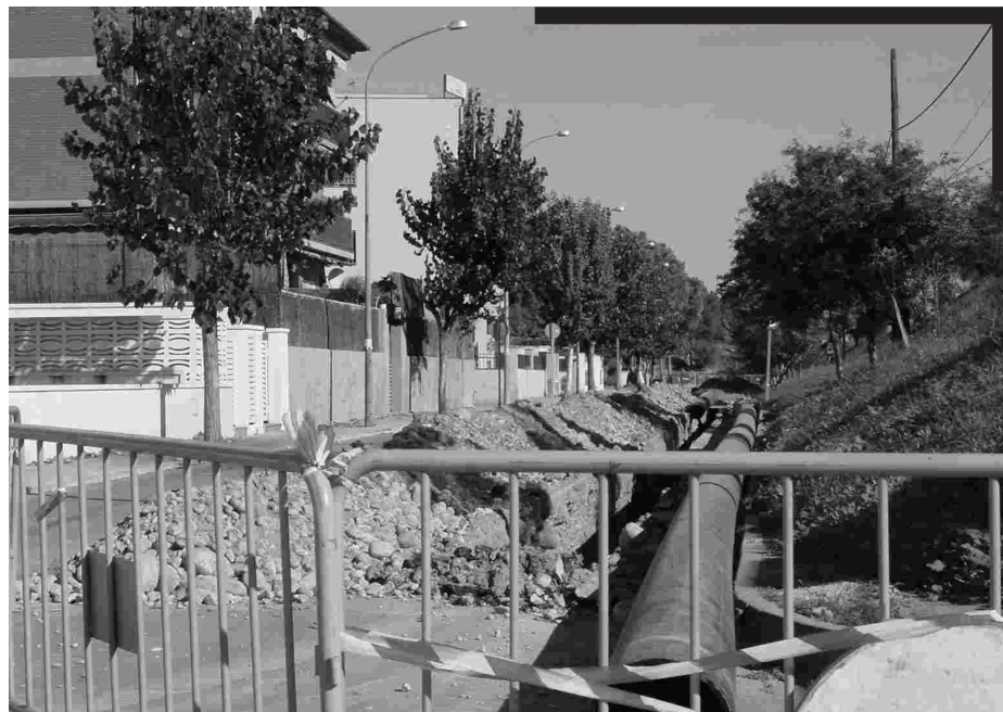
Les inundacions del sector Marítim es minimitzaran amb les obres de l'estació de bombeig
