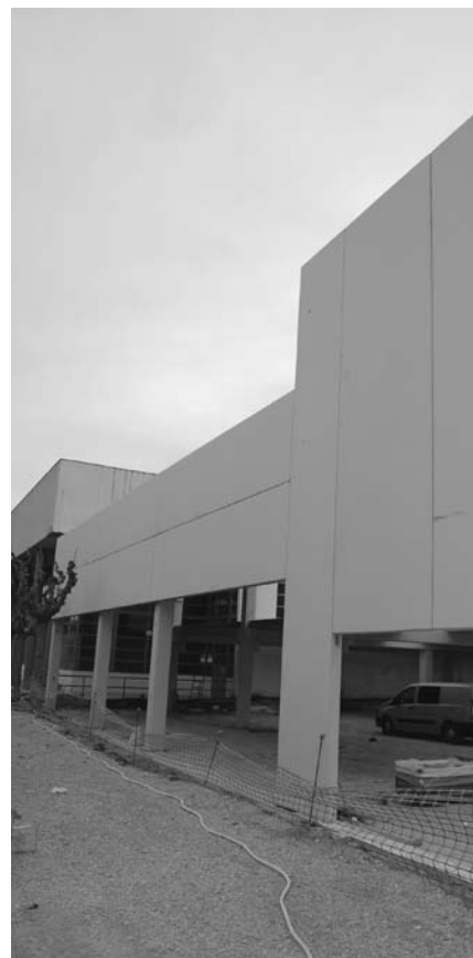
Obres del nou pavelló
