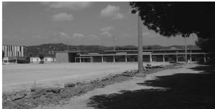
Imatge de les obres de la gespa del camp de futbol
